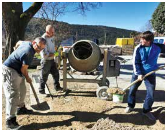
Obnova južnega vhoda v MD
